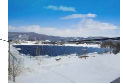
いちご遠軽清川 ECO発電所 1.12MW
