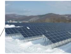
いちご遠軽東町 ECO発電所 1.24MW
