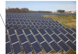
いちご豊頃 ECO発電所 1.02MW
