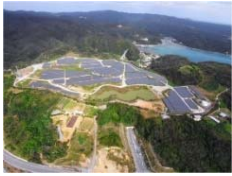
いちご名護二見 ECO発電所 8.44MW
