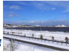
いちご元紋別 ECO発電所 1.40MW
