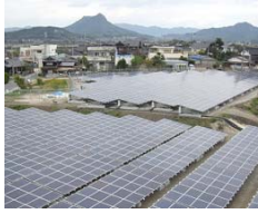
いちご山口秋穂西 ECO発電所 1.24MW
