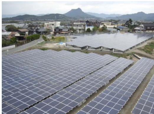
いちご山口秋穂西ECO発電所(1.24MW)
