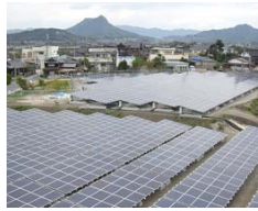
いちご山口秋穂西 ECO発電所 1.24MW
