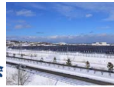
いちご元紋別 ECO発電所 1.40MW
