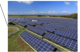
いちご中標津緑ヶ丘 ECO発電所 1.93MW
