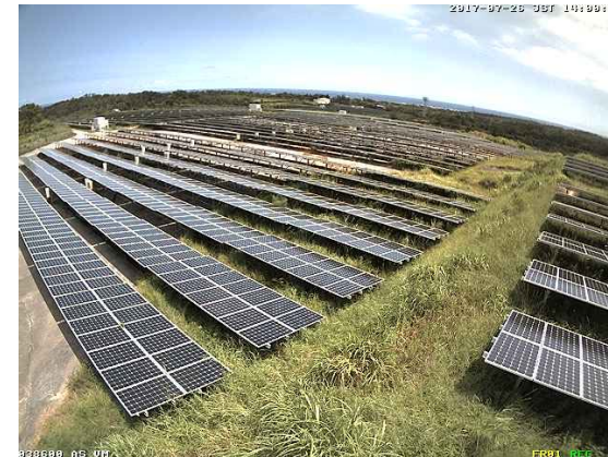
WEBカメラによる発電所の様子
