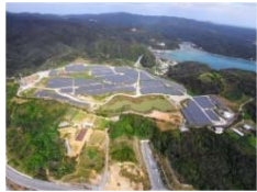
いちご名護二見 ECO発電所 8.44MW
