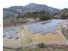
いちご伊予中山町 出渚ECO発電所 1.23MW
