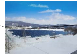
いちご遠軽清川 ECO発電所 1.12MW
