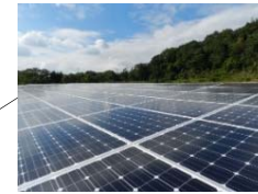
いちご桐生奥沢 ECO発電所 1.33MW
