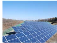
いちご安平遠浅ECO発電所 1.16MW
