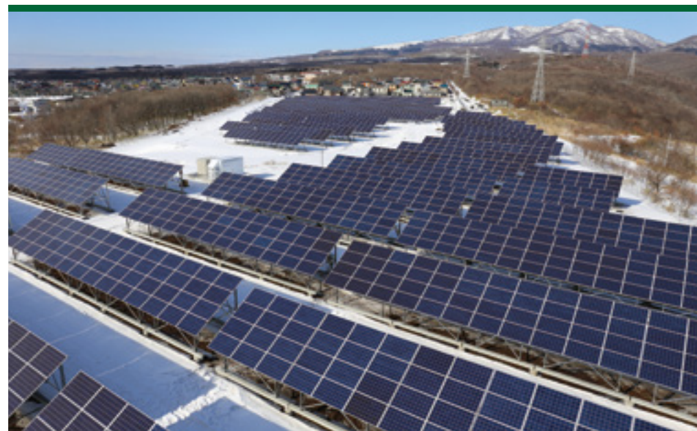
いちご室蘭八丁平ECO発電所（北海道室蘭市）
