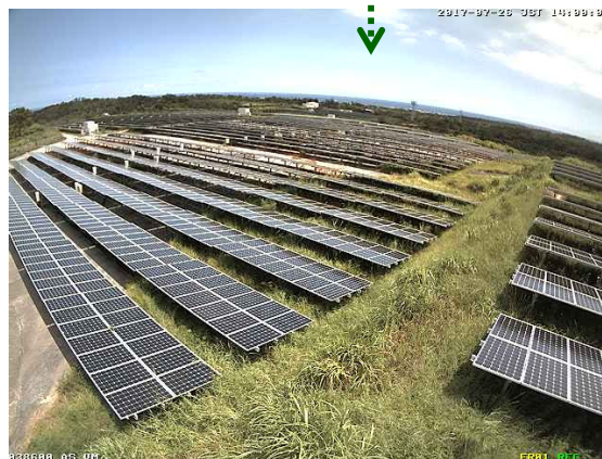
WEBカメラによる発電所の様子
